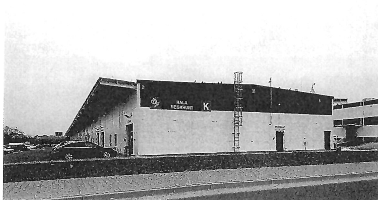
Fot. 1 Elewacja wschodnia
