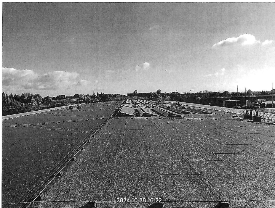
Fot. 3 Widok dachu z panelami fotowoltaicznymi umieszczonymi w pierwszym etapie.
